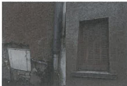
↑ - Etat de la façade Coté Impasse des boucheries
