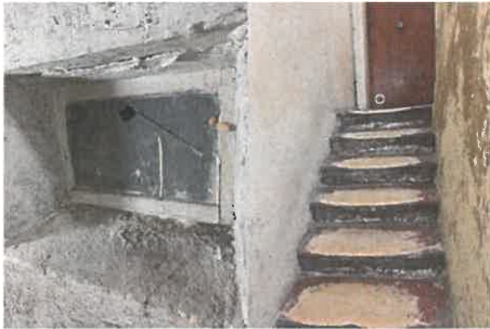
↑ ↑ -fenêtre locaux communs et escalier donnant sur l'appartemen 1 er étage
